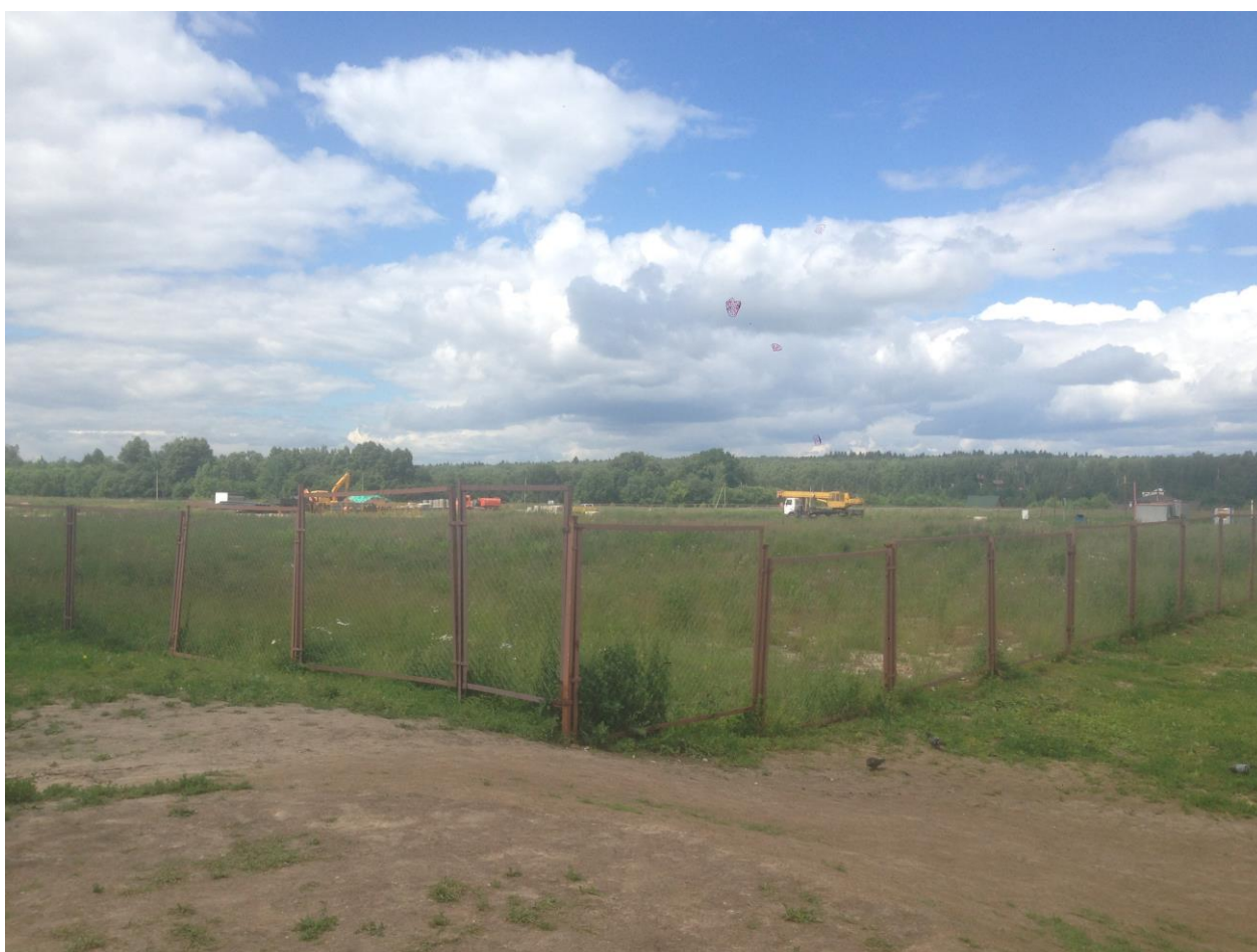
Июнь 2017. Строительство корпуса 4/3:
