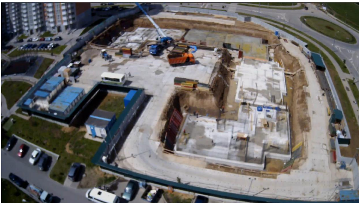
Июнь 2017. Строительство корпуса 6/1:
