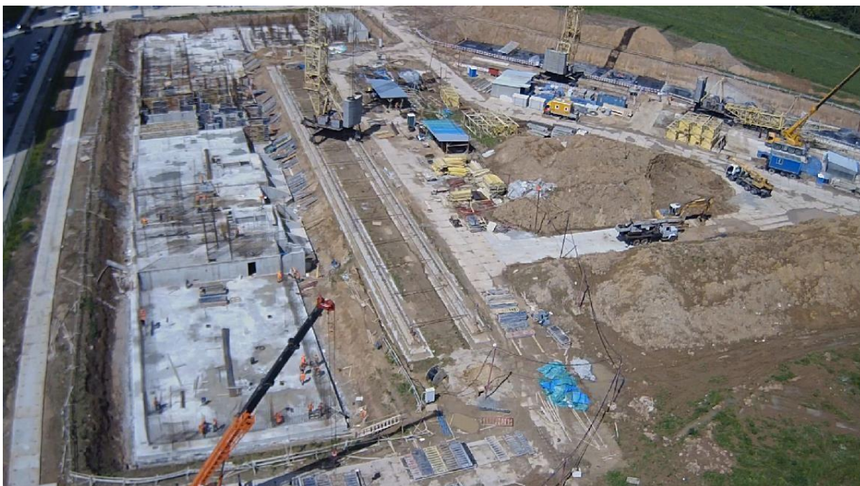
Июнь 2017 г. Строительство корпусов 4/1 и 4/2:
