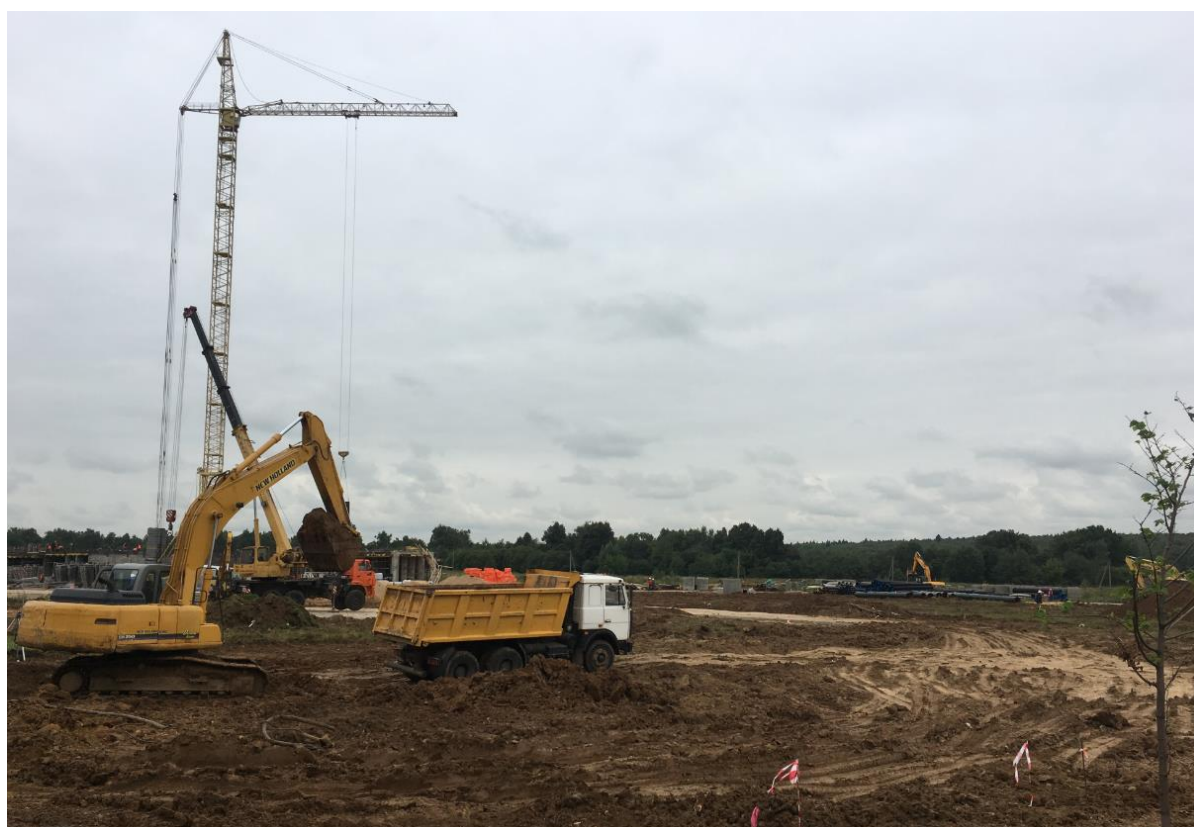
Август 2017. Строительство корпуса 4/3:
