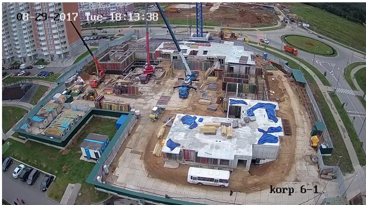
Август 2017. Строительство корпуса 6/1:
