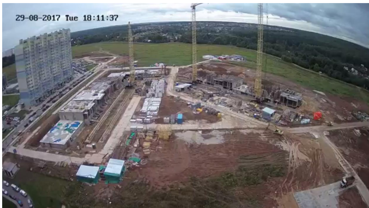
Август 2017 г. Строительство корпусов 4/1 и 4/2:
