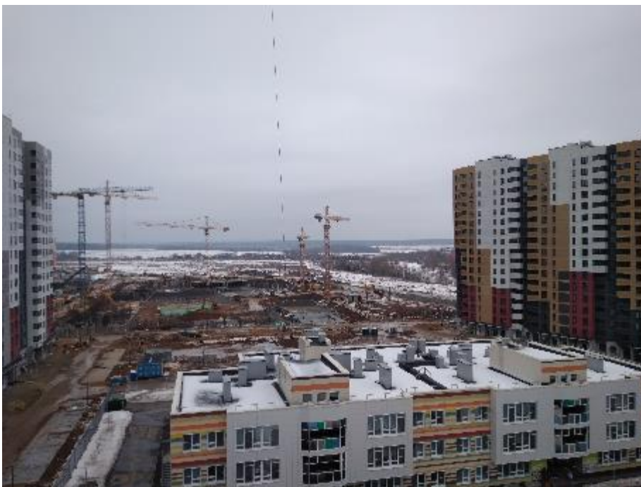
Январь 2017 г. Строительство корпуса 10/1:
